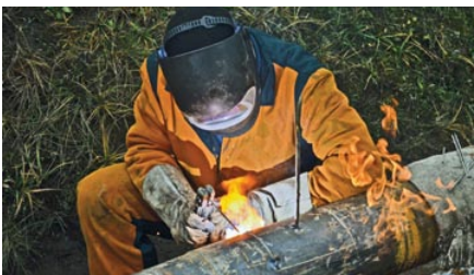
Сварка стыка газопровода
