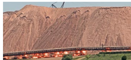
Замена конвейерного тракта по галерее № 3 РУ-2 с применением направленного взрыва
