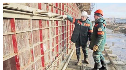
Строительство склада руды № 2 на Петриковском ГОКе
