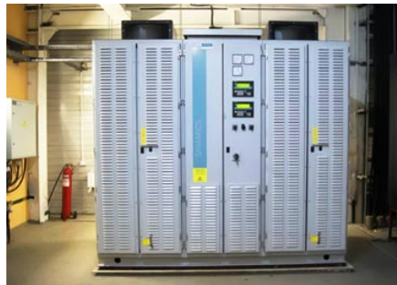
Преобразователь якорной цепи и цепи возбуждения подъемного двигателя
