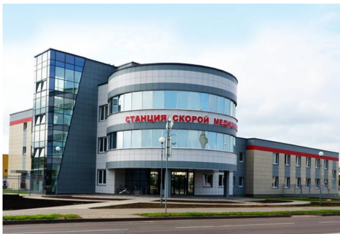
Станция скорой помощи, г. Брест
